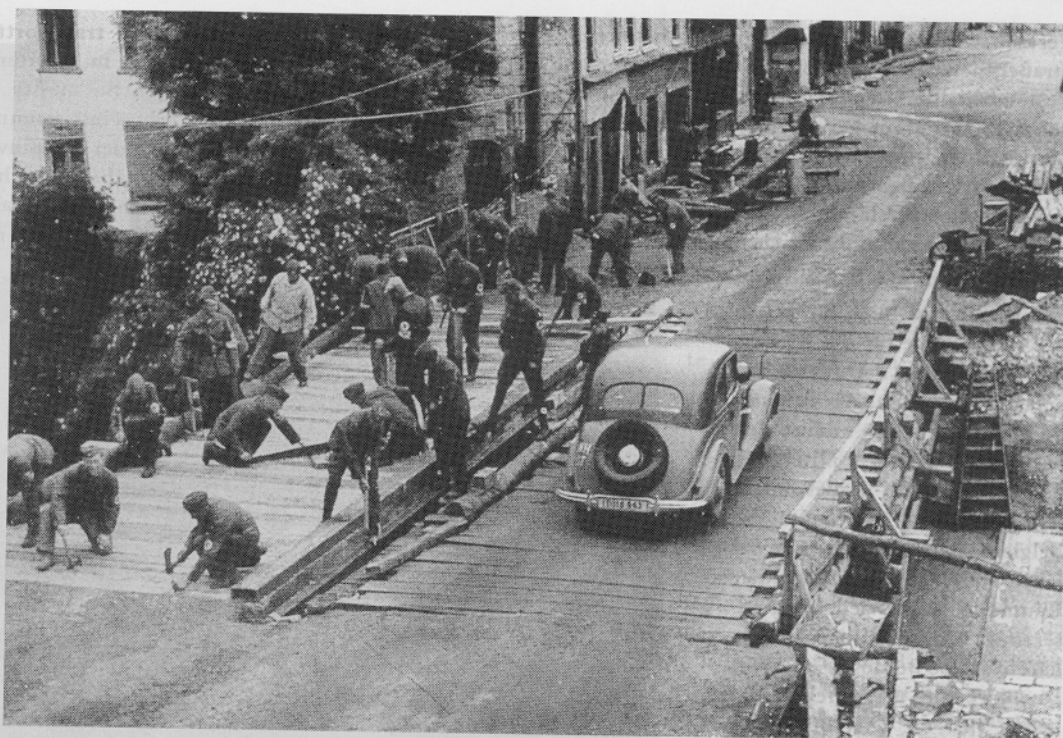
Notbrücken wurden sofort hergestellt
