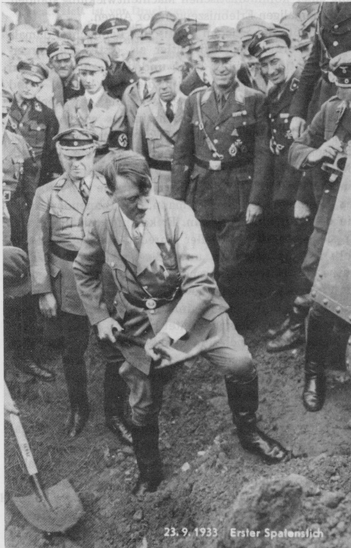
Erster Spatenstich am 23.9.1933.
