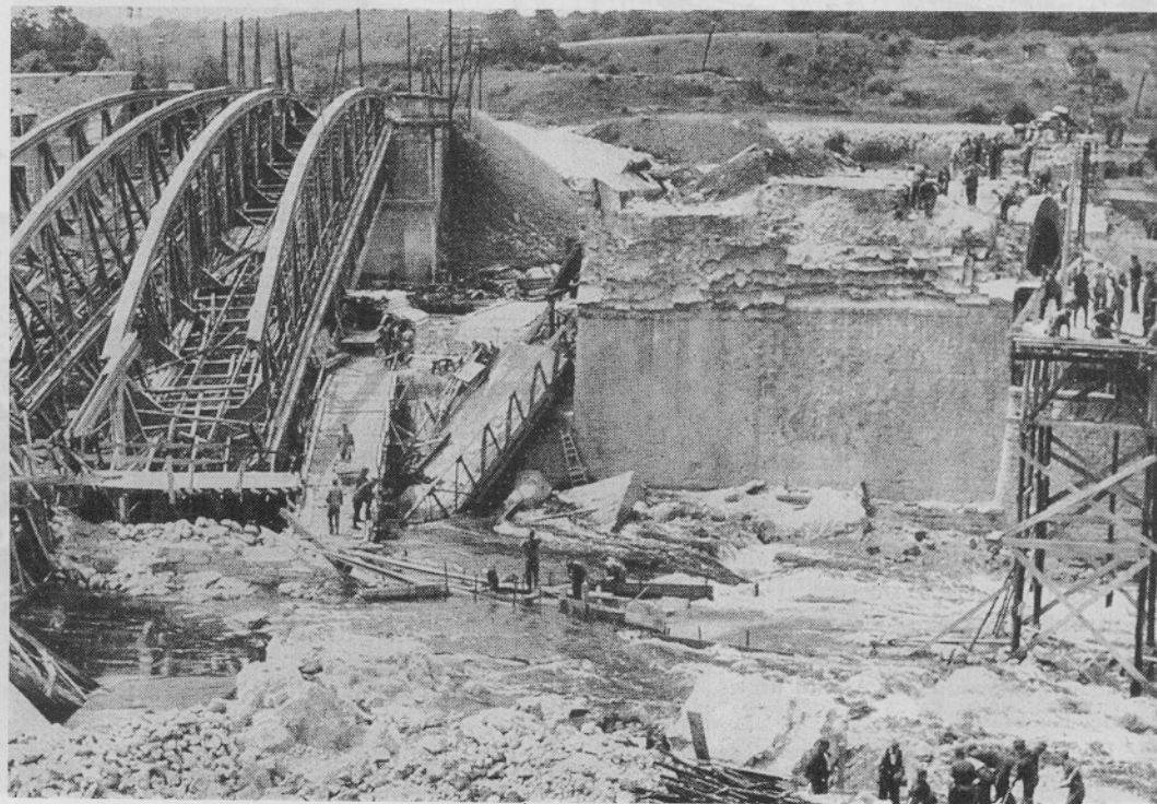
Unmittelbar hinter der Front, Baueinsatz z.T. unter Artilleriebeschuß
