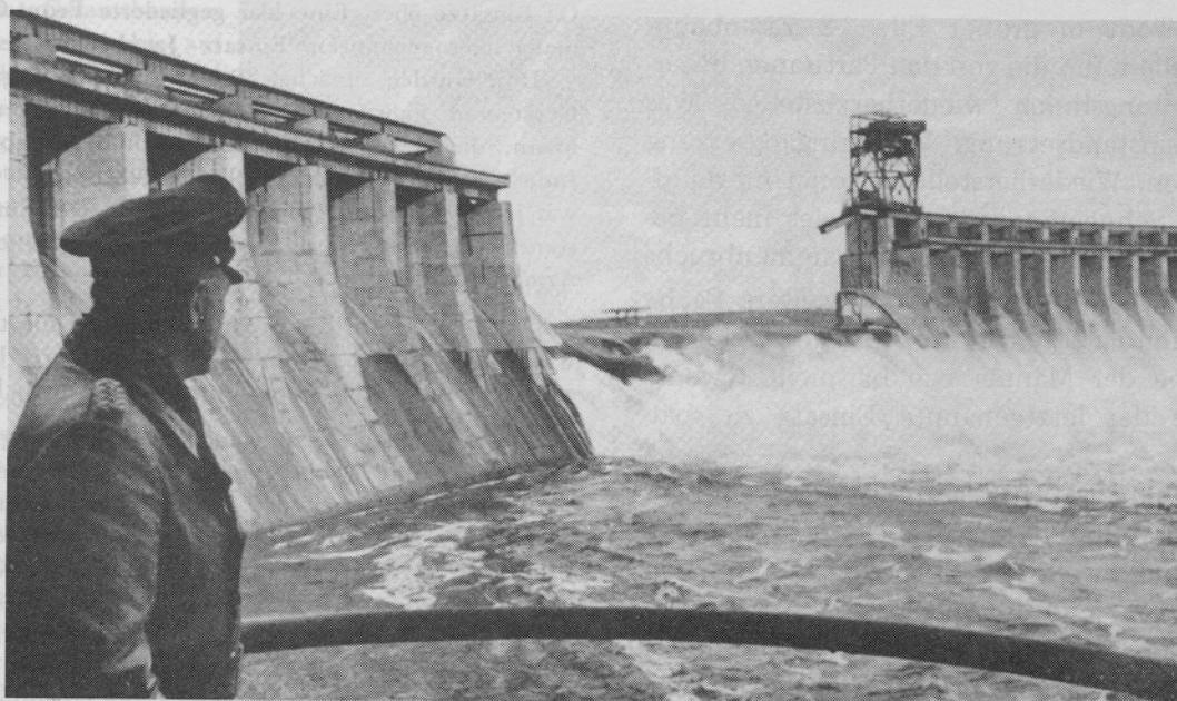
Dr. Fritz Todt am zerstörten Kraftwerk Saporoshje, Ukraine, dessen Wiederherstellung die OT in die Hand genommen hat. Staudammlänge über den Dnjepr = 760 m. Dieses Kraftwerk versorgte zahlreiche große Industriekombinate.
