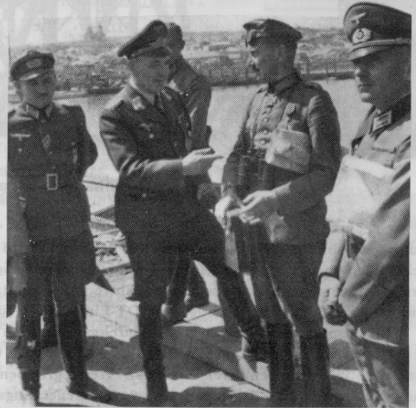
An einer Brückenbaustelle im Osten
