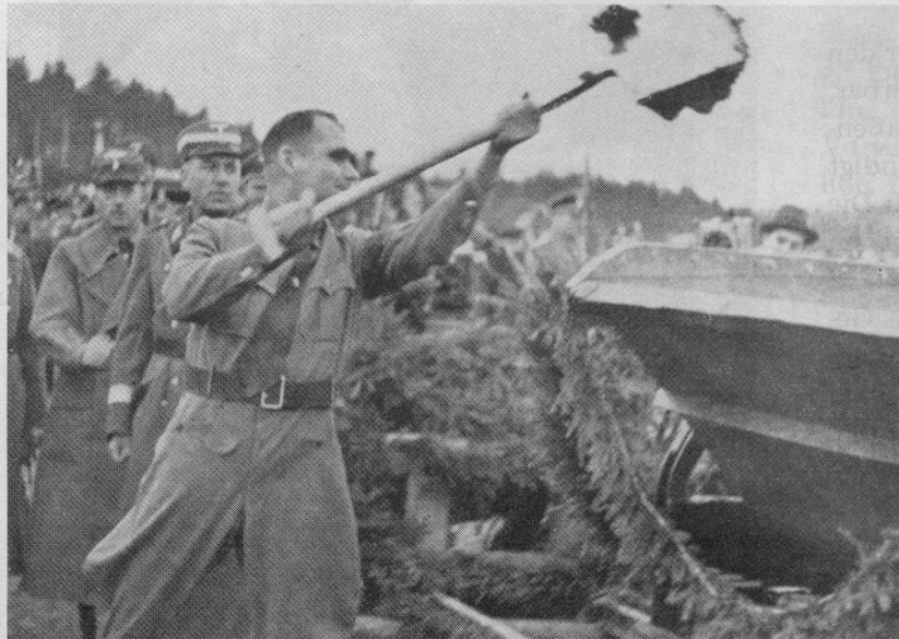
Unmittelbar nach der Angliederung des Sudetenlandes an Deutschland wird dort der Reichsautobahnbau begonnen. Rudolf Heß vollführte hier als "Stellvertreter des Führers" den ersten Spatenstich.
