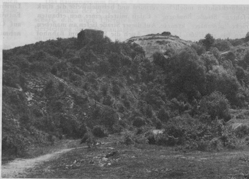
Atlantikwall - V 2 Anlage Wizernes Kuppel und Entlüftungsturm
